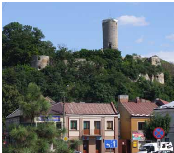
Fot. 1. Iłża. Zabudowa miasta z Górą Zamkową w tle. Zieleni inwazyjna pokrywa obwarowania podzamcza niszcząc strukturę zabytkowych murów obronnych konserwowanych w latach 70. XX w. Fot. M.L. Lewicka, 2011.
