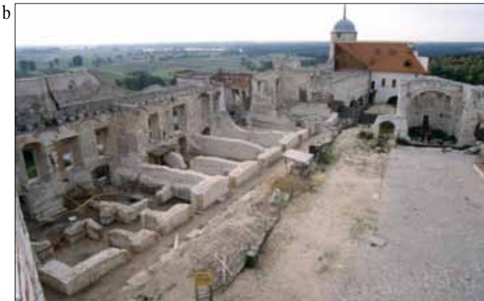
II. 5. Janowiec, zamek. Przykład zamku wpisanego jako ruina („ruiny zamku, 1508-26, 1577-87, XVII, po 1975, 2 poł. XVIII”, wpis. z 3.06.1947 i z 23.01.1960; i nr A/935/1-4 z 12.02.1987) i częściowo odbudowanego. A. Stan w roku 2002; B. Stan w roku 2010. Fot. J. Lewicki 2010.
