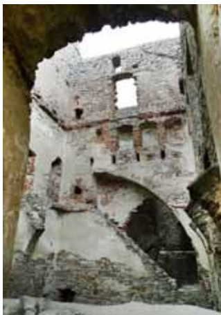
Ryc. 8. Zamek Krzyżtopór – wewnątrz zespołu pomieszczeń części pałacowej z czytelnymi relikwiami sklepień i gniazd stropu drewnianego. Dla całego zamku zespół prof. E. Dąbbskiej-Śmiałowskiej opracował projekty wykonawcze odtworzenia brakujących sklepień stropów i dachów. Ich realizacja z całą pewnością najlepiej uchroniłoby zamek przed wpływem warunków atmosferycznych i umożliwiłoby przywrócenie mu funkcji użytkowej – wymaga to jednak zmiany dotychczas przypisanej zamkowi doktryny konserwatorskiej... /fot. autor/
