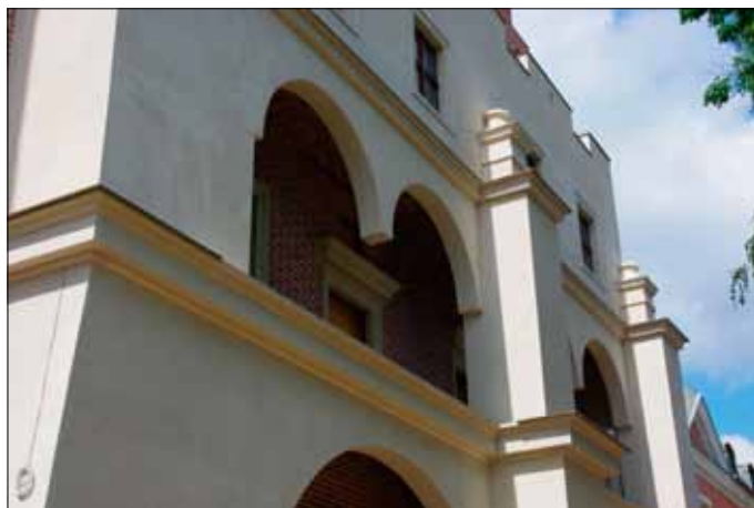
Fot. 3. Nowe zamkowe loggie w oczekiwaniu na wstawienie kolumn. Fot. T. Ratajczak.
