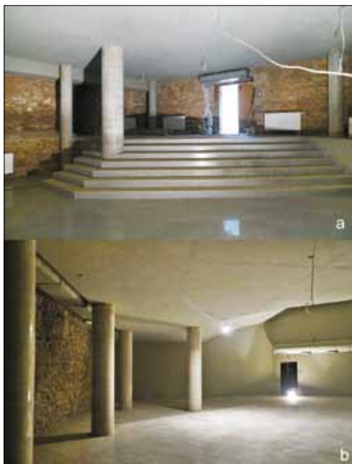
Ryc. 6. Zamek Krzyżtopór – nowa kubatura utworzona pomiędzy murami bastionu północno-wschodniego po usunięciu pierwotnego wypełnienia gruntem i wykonaniu nad nim monolitycznego żelbetowego stropu. Uzyskane w ten sposób powierzchnie są niewielkie i nie zapewnią spełnienia potrzeb obsługi intensywnego ruchu turystycznego. Podobno koszt nowych zadań i kubatur to zaledwie 1/3 wszystkich środków dedykowanych na tą konserwatorską inwestycję... /fot. autor/. A – widok w kierunku wejścia, B – główne pomieszczenie bastionu.
