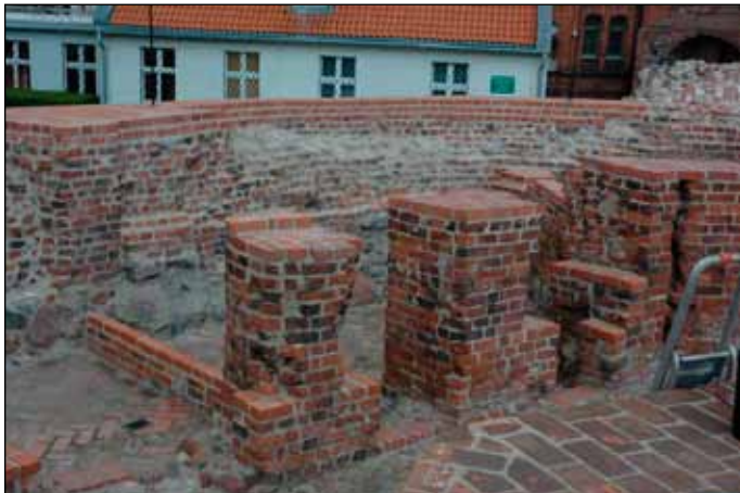
Fot. 4. Zabezpieczenie korony muru reliktyw na zamku krzyżackim w Toruniu.
