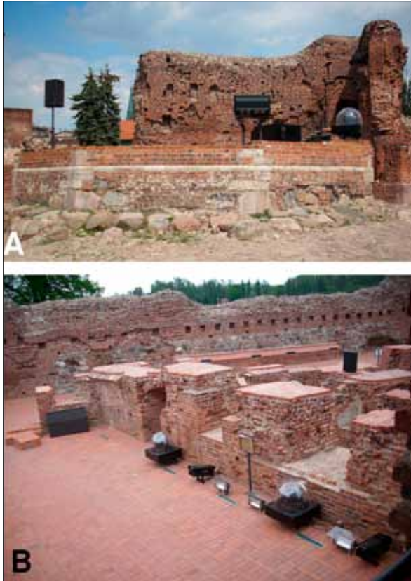
II. 8. Toruń – ruiny zamku krzyżackiego po zainstalowaniu urządzeń dla nowego programu „światło i dźwięk”. A – wieża „udekorowana” aparaturą rzucającą się w oczy po wejściu w ruiny. B – jedno z dwóch skrzydeł, w które wstawiono zbyt liczną aparaturę.
