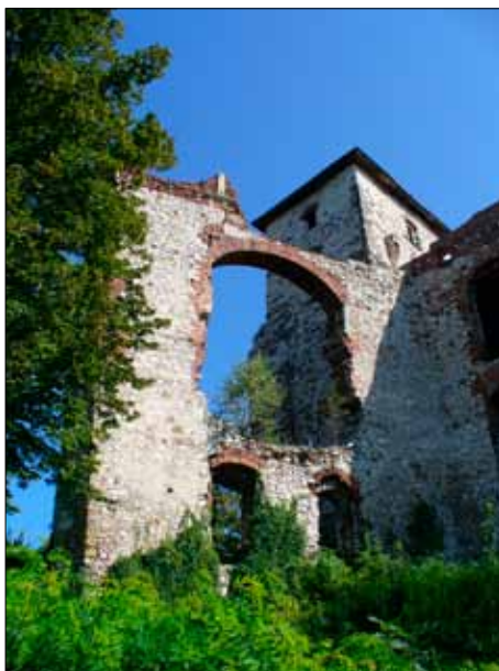
Fot. 1. Tenczyn. Fragment skrzydła południowego górnego zamku. Widoczny wprowadzony przez Z. Hendla ok. 1910 r. łęk stabilizujący grożący wcześniej zawaleniem filar z lewej strony. W głębi wieża bramna zamku górnego. Fot. Autor, 2010 r.
