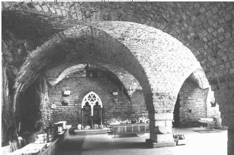
Il. 13. Toruń – ruiny zamku krzyżackiego po pracach. Piwnica po odbudowie sklepień adaptowana na lapidarium detalu. Odtworzenie sklepień czytelne przez zastosowanie współczesnej cegły, a jednocześnie zsynchronizowana z autentycznymi fragmentami dzięki pomurowaniu w dawnej technice na tzw. wycisk.
