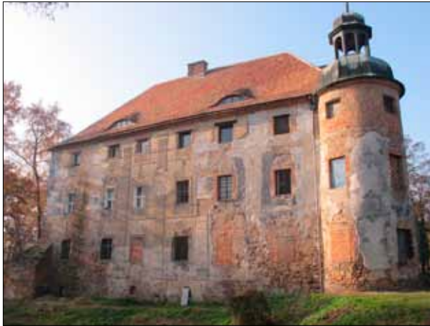
Fot. 1. Zamek w Broniszowie, elewacja wschodnia wraz z wieżą stan 2011 r.
