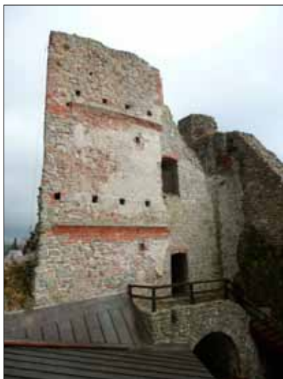
Fot. 2. Zamek w Czorsztynie, południowa ściana Baszty Baranowskiego po uzupełnieniu (reintegracji).
