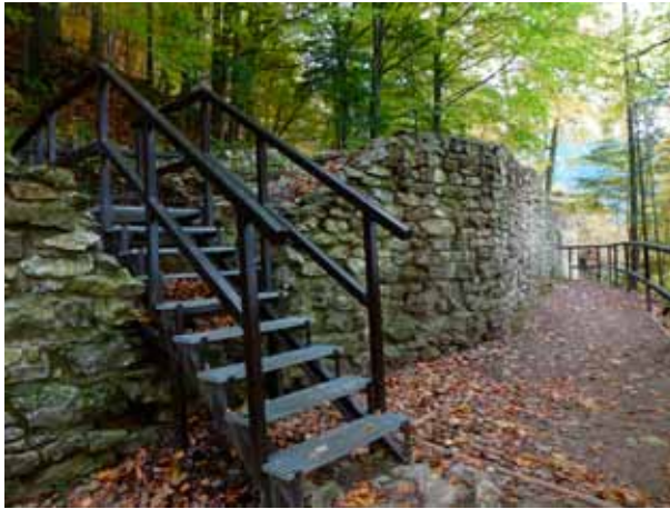
Fot. 6. Zamek Pieniny, fragment muru tarczowego od strony zewnętrznej i przejście dla zwiedzających.
