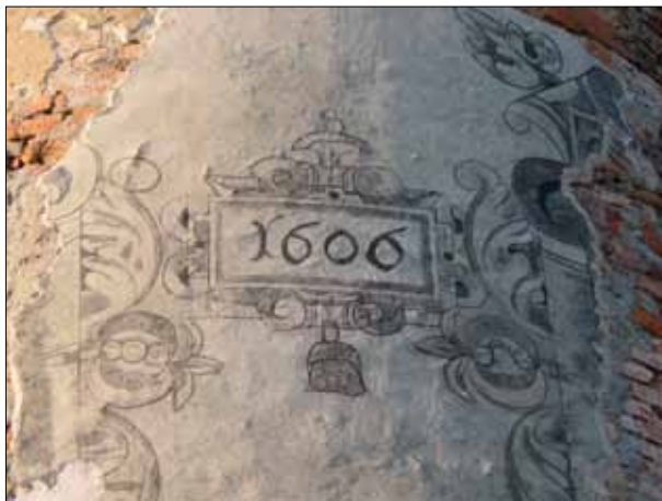
Fot. 5. Sgraffia na wieży po rekonstrukcji, kartusz z datą.
