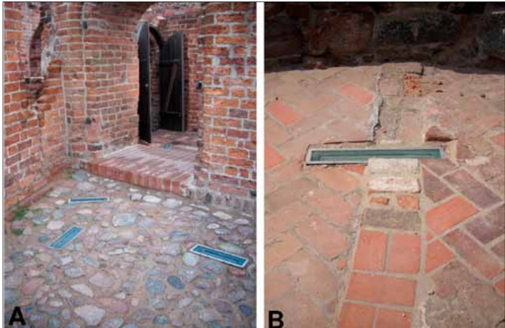
Il. 9. Tonuń – ruiny zamku krzyżackiego po zainstalowaniu podświetlenia murów. Rzucające się w oczy źle dobrane, o kształtach sprzecznych z nawierzchnią i źle rozmieszczone elementy oświetlenia. A – liczne lampy w bruku dziedzińca. B – liczne lampy w posadzkach pomieszczeń, a nawet na uczynionym murze działowym.
