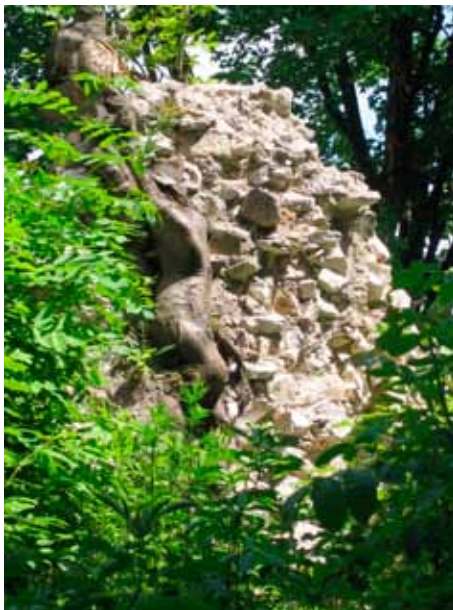
Fot. 2. Tenczyn. Widoczny stan murów szyi barbakanu przed rozpoczęciem prac zabezpieczających. Fot. Autor, 2010 r.
