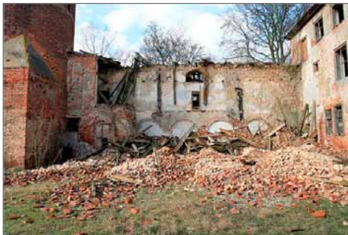
Rys. 6. Zawalone w 2008 r. skrzydło zamku w Swobnicy. Źródło: http://www.czejarek.pl/swobnica/okna/kat002.htm .
