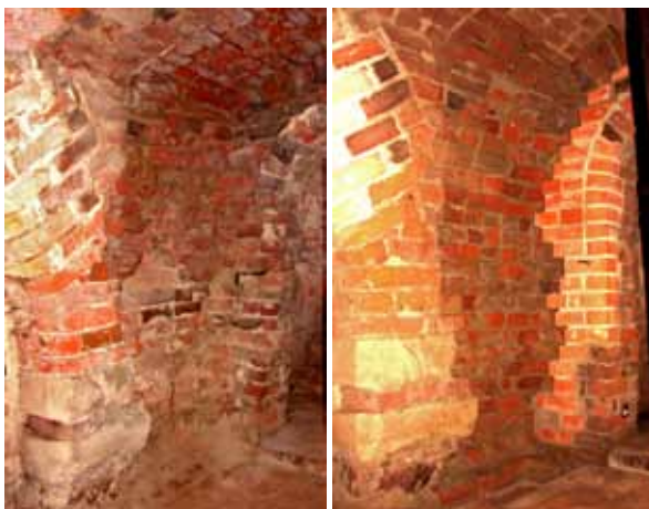
Fot. 6. Wejście z szyi do piwnicy skrzydła południowego: A – przed konserwacją, B – stan po konserwacji, fot. L. Narębski.
