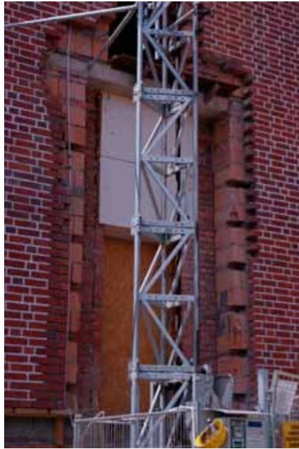
Fot. 4. Struktura nowych murów zamku poznańskiego, z ceramicznych pustaków licowanych cegłą. Fot. T. Ratajczak.
