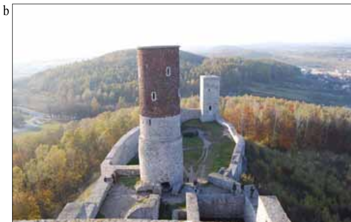
II. 2. Chęciny, zamek. Przykład zamku wpisanego jako ruina („ruina zamku, XIII/XIV, XVI”, wpis nr A.234 z 9.0.1932 i z 15.02.1967) i częściowo odbudowanego w formie trwałej ruiny. A. Stan w latach 50 XX wieku; B. Stan obecny. Fot. J. Lewicki 2010.
