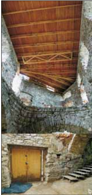
Ryc. 5. Zamek Krzyżtopór i nowe elementy architektoniczne: a – zmieniona konstrukcja i kształt dotychczasowego zadaszenia nad skrzydłem północno-zachodnim zamku, choć z wystarczyło jedynie wymienić pokrycie nad zadaszeniem dotychczasowym... b – świeżo wykute w ścianie bastionu północno-wschodniej wejście do kubatur „uzyskanych” w przylegającym do niej bastionie – zastanawiający przykład „nowego podejścia” do dotychczasowej doktryny definiującej zamek jako trwałą ruinę. /fot. autor/
