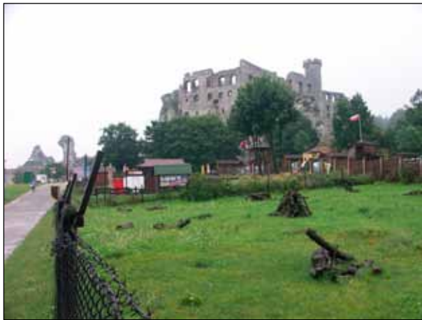
Ryc. 5. Zamek Ogródzieniec. Widok od strony współczesnego dojazdu. Współczesne uzupełnienia ahistoryczne – poprawna lokalizacja i skala, a negatywna forma uzupełnień i krzykliwa kolorystyka. Pozytywem jest usuwalność elementów. (fot. C.Głuszek, 2011).
