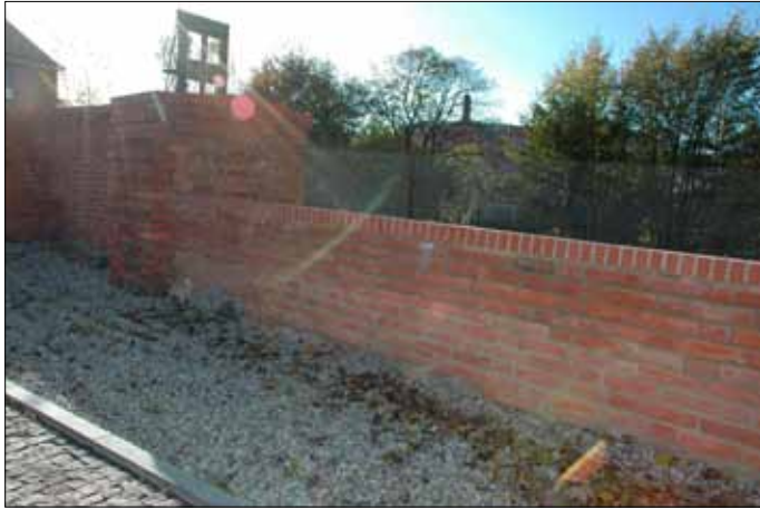
Fot. 3. Przemurowana korona muru, z zastosowaniem hydrofobowej, cementowej warstwy izolacyjnej, a w zasadzie odbudowane mur w formie przyjętej w latach 60. XX w.
