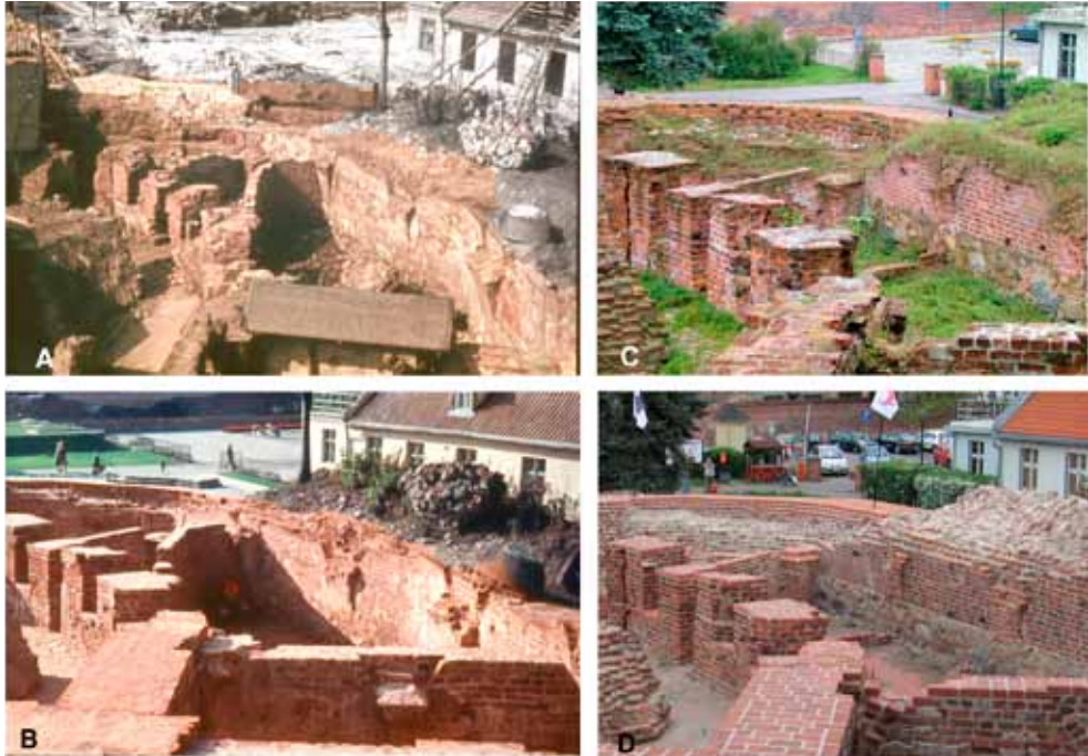
Il. 7 Toruń – ruiny zamku krzyżackiego. Strona północna. Przykład jak trudno ustrzec się przed usztywnieniem ruin. A – malowniczy fragment murów przed zabezpieczeniem korony w 1964 r. B – ten sam fragment po zabezpieczeniu korony w 1966 r. C – po 40 latach – malowniczość tym ruinom przywróciła samorodna zieleni. D – ponowne usztywnienie korony po pracach w 2011 r.
