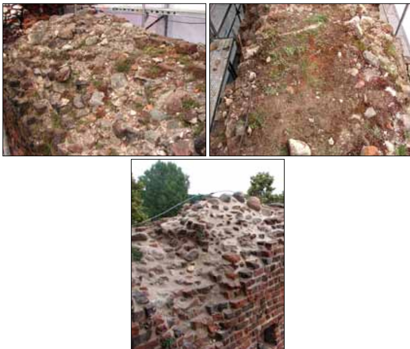
Fot. 4. Korona muru obwodowego wschodniego: A, B – przed konserwacją, C – stan po konserwacji, fot. L. Narębski.
